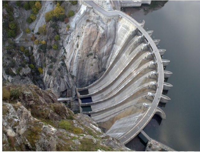
Figura 1.2.1. Presa arco. Aldeadávila (España-Portugal).
